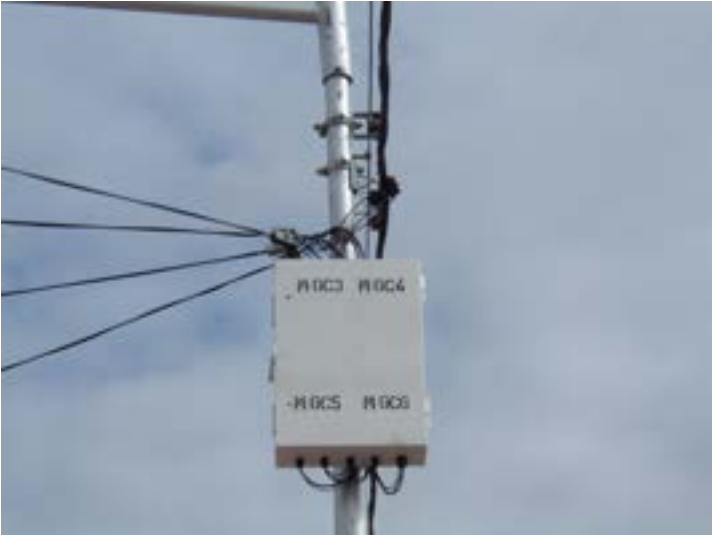
UBICACIÓN DE LAS CAJAS PERPENDICULARES A LA LÍNEA DE DISTRIBUCIÓN.
